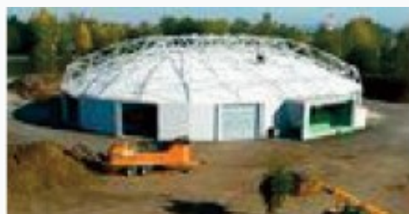
L'usine de compostage des boues
