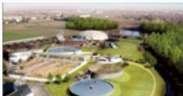
La station d'épuration Cugnaux
