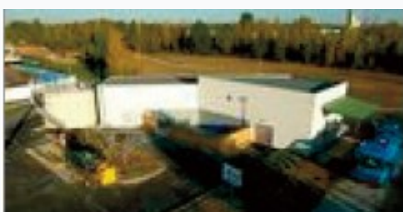
L'usine de traitement des sous-produits de l'assainissement
